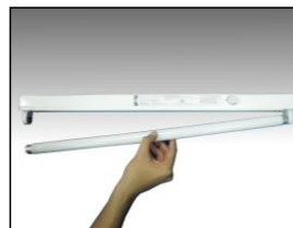
Langkah 8: Pasangkan tiub pada pemegang lampu dengan betul dan pusingkan tiub 90°.
