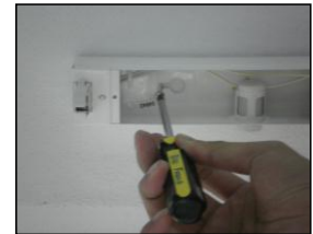
Langkah 5: Ikatkan rangka lampu pada siling selepas wayar bekalan dimasukkan kedalam lubang bekalan .
