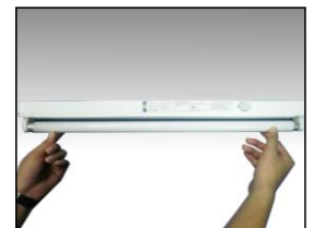
Langkah 8: Pasangkan tiub pada pemegang lampu dengan betul dan pusingkan tiub 90°.
