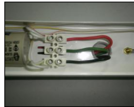
Langkah 6: Sambungkan wayar bekalan pada penyambung yang disediakan.
