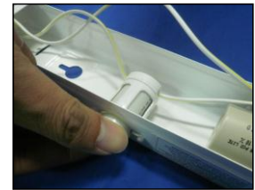
Langkah 4: Masukkan semula "starter" kedalam "starter holder" seperti yang ditunjukkan dalam gambarajah.
