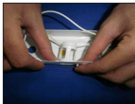
Langkah 3: Keluarkan "starter" daripada "starter holder" dan masukkan "starter
